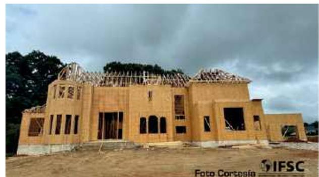
Foto 2 - Residencia en construcción con elementos en madera.
