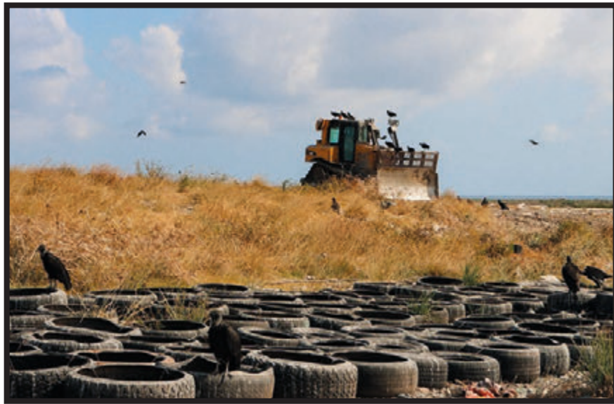
RELLENO SANITARIO EN LA ISLA DE COZUMEL, Quintana Roo. Este es considerado un sitio de disposición final de residuos sólidos urbanos. Foto: Juan Ibarra/Animal Político
