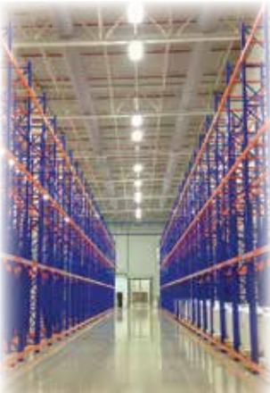
**RACK SELECTIVO SENCILLO Y DOBLE DEEP** Acabado en pintura epóxica poliéster horneada
