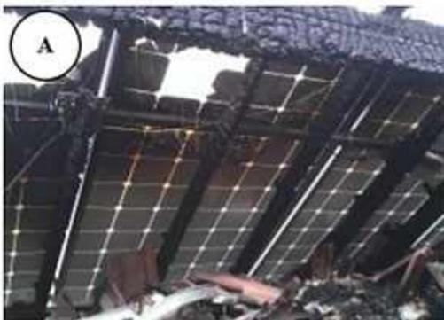
(A) Techo quemado con partes del sistema fotovoltaico intactas.
