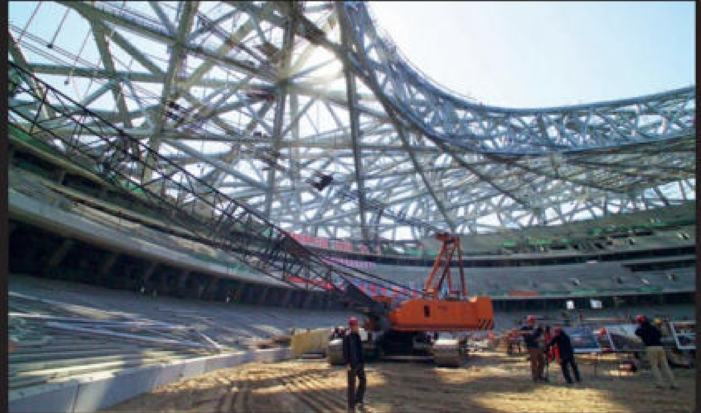
17 de abril de 2006. El Nido de Pájaro (el Estadio Nacional de China), uno de los nuevos edificios emblemáticos del Eje Central de Beijing, en proceso de construcción.
